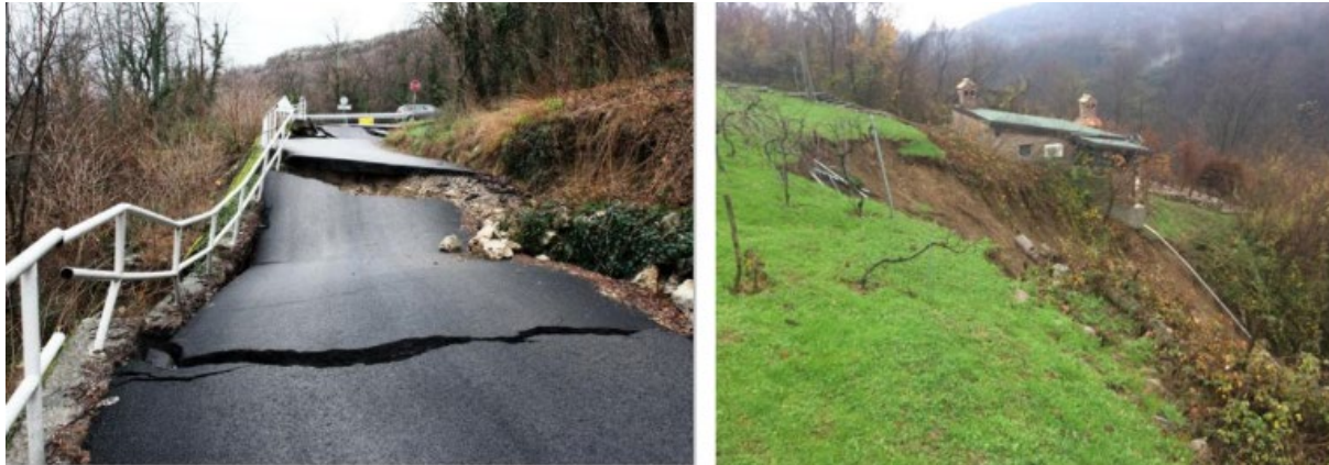
Slika 34. Urušena cesta Grohovo – Lopača zbog aktiviranja klizišta Grohovo, 2014.god. (lijevo) i Aktivirano klizište u selu Lopača – u studenome 2016. godine (desno)
