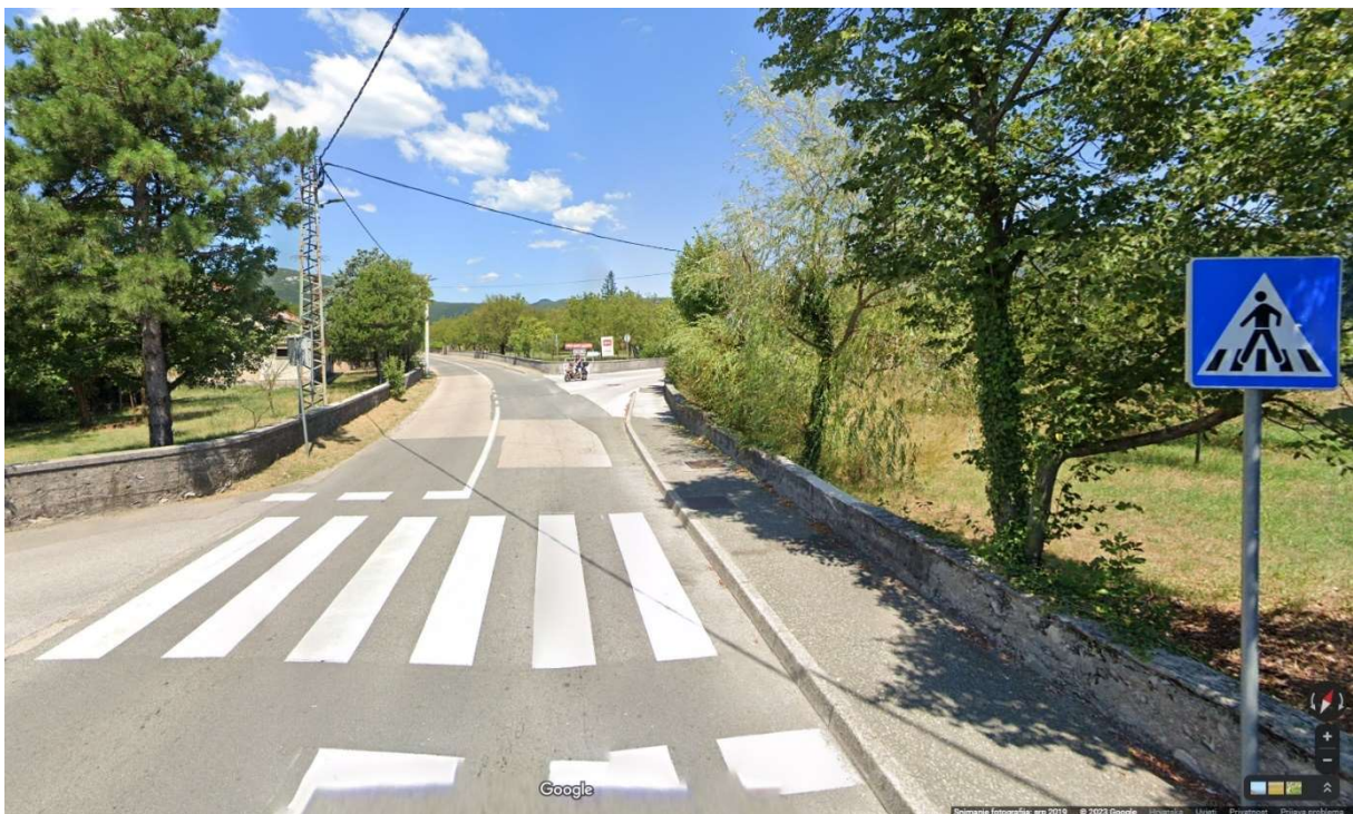
Slika 1. Lokacija izvođenja radova na križanju LC 58021 i ŽC 5055
